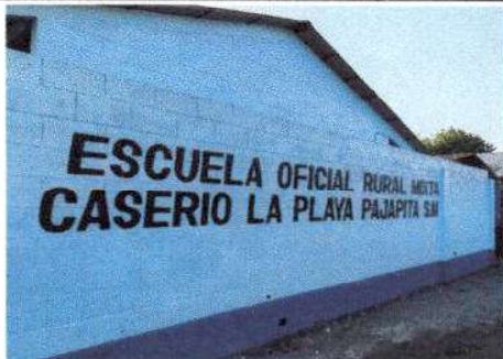
Foto 5: Pintura en muros exteriores de muro perimetral
