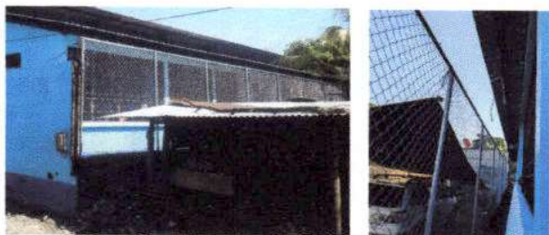
Foto 7: Reparación de tubo hg y malla galvanizada en muro perimetral
