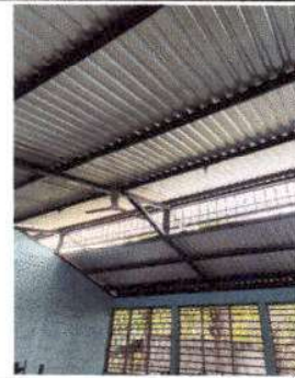
Foto 2: Sustrucción de lámina por lámina troquelada aluzinc calibre 26 y mantenimiento a estructura de soporte de metal en módulo 1 y cocina
