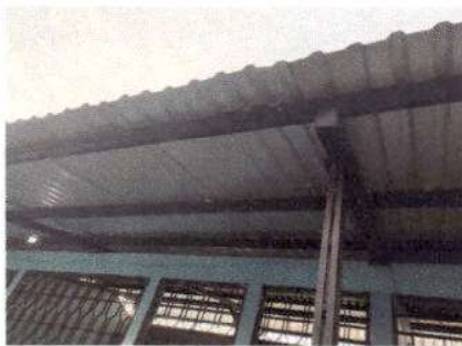
Foto 1: Sustrucción de estructura de soporte de metal por soporte de metal en módulo 1
