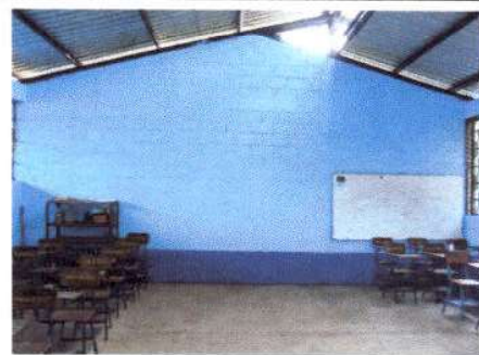
Foto 4: Pintura en muros interiores módulo 1, 2, 3, 4, 5
